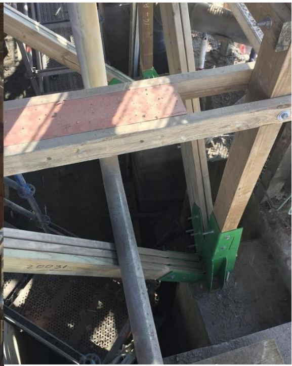
Figura 20: Reparación de placas base
