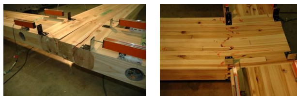
Figura 10: Falla de la articulación
