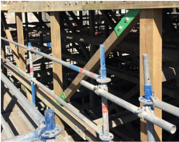
Figura 17: Restitución columnas perimetrales
