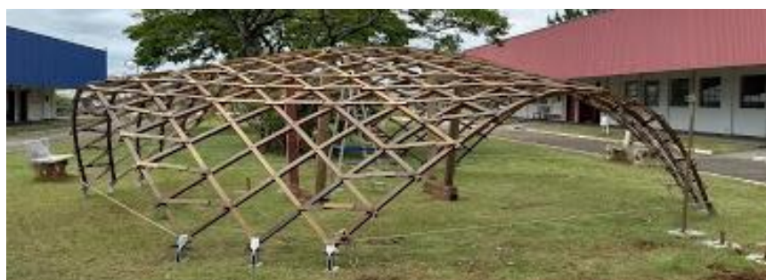
Figura 10: Forma da estrutura construída
