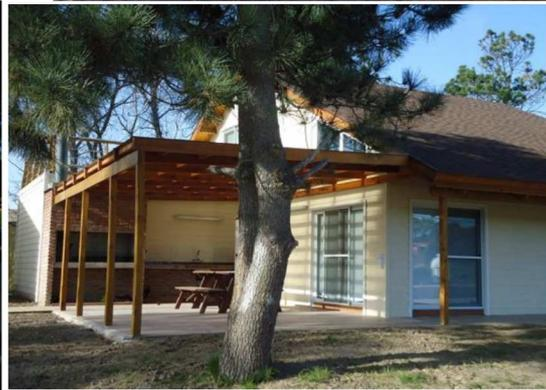
A partir e que el hormigón ciclópeo se encuentre en un 70 % de su resistencia (aproximado a los 7 días de llenado) se comenzó la colocación de las vigas de rollizos de Eucaliptus Grandis, conformando el entramado estructural general de Poste y Viga, mediante tornillos tirafondos galvanizados y platinas metálicas.
