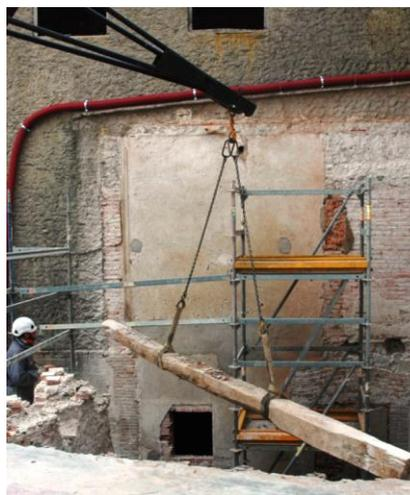
*Figura 1: Izquierda aspecto de uno de los forjados del que se extrajeron vigas. Derecha extracción y manipulación de una viga en la obra.*
