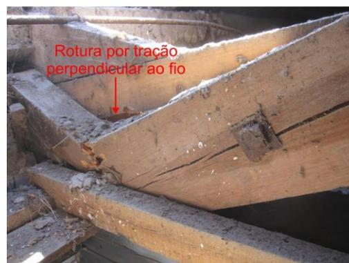
Figura 5: a) Rotura da peça central b) Rotura da ligação
