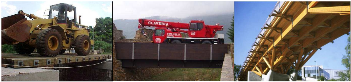
Figura 1. Imágenes de puentes: a) tablero de madera tensada; b) sistema vigas y riostras de MLE y c) tablero de madera contralaminada (Baño et al., 2014)
