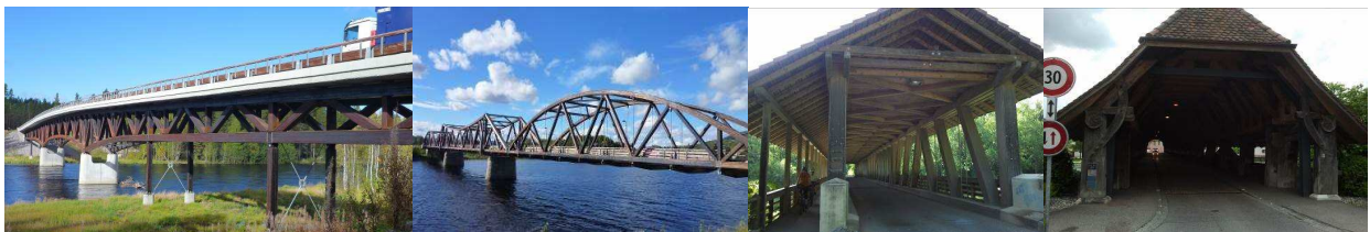
Figura 2. Puentes vehiculares en celosía (Baño et al., 2014)
