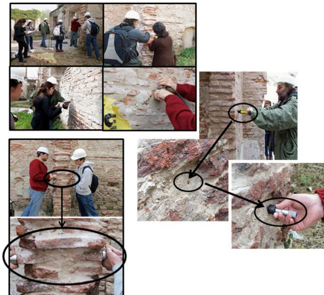
Figura 3.39. Aplicación de técnicas de Ensayos No Destructivos in situ.
