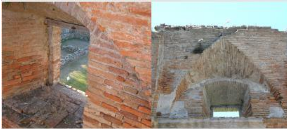
Figura 4.5: Detalle de vanos en arranque de bóveda de la Capilla Calera de las Huérfanas (se observan las jambas abocinadas y los dinteles en arco).
