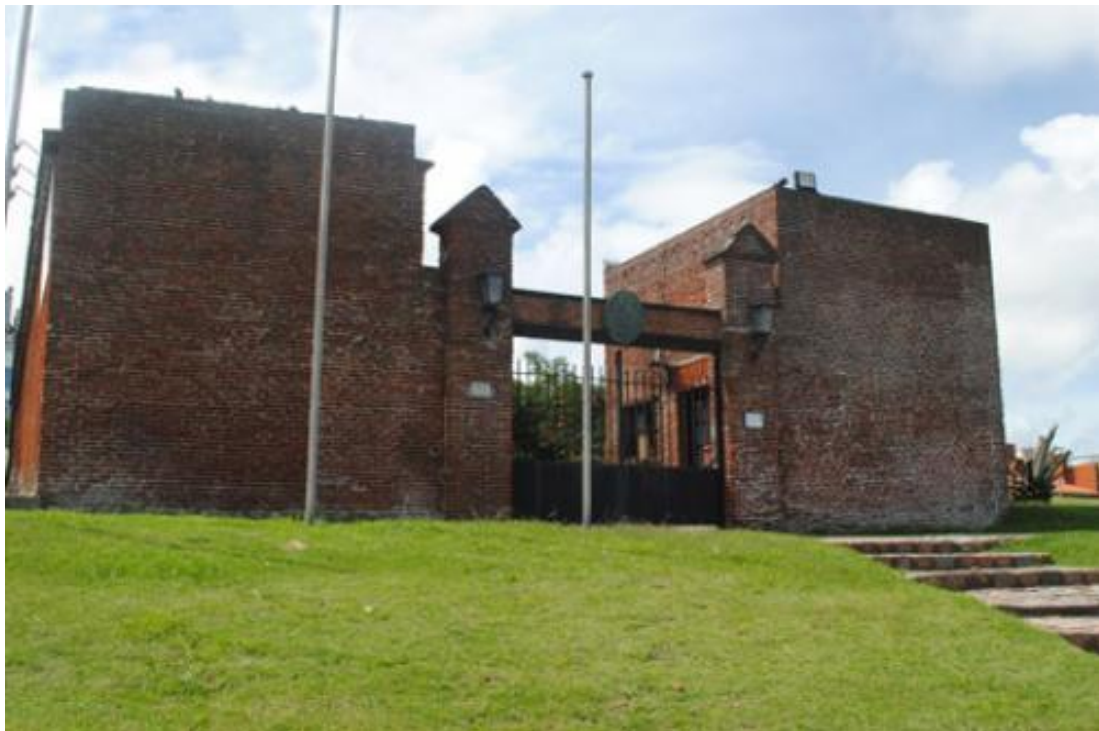
Figura 3.45. Vista desde la Rambla de la Aduana de Oribe.
