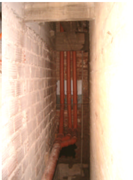
Se completaron los trabajos de cambio del trazado de los desagües pluviales de la azotea del Cuerpo Central y se trabaja en las instalaciones de abastecimiento de agua potable.
