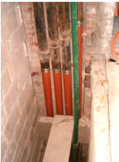
Se completaron los trabajos de cambio del trazado de los desagües pluviales de la azotea del Cuerpo Central y se trabaja en las instalaciones de abastecimiento de agua potable.
