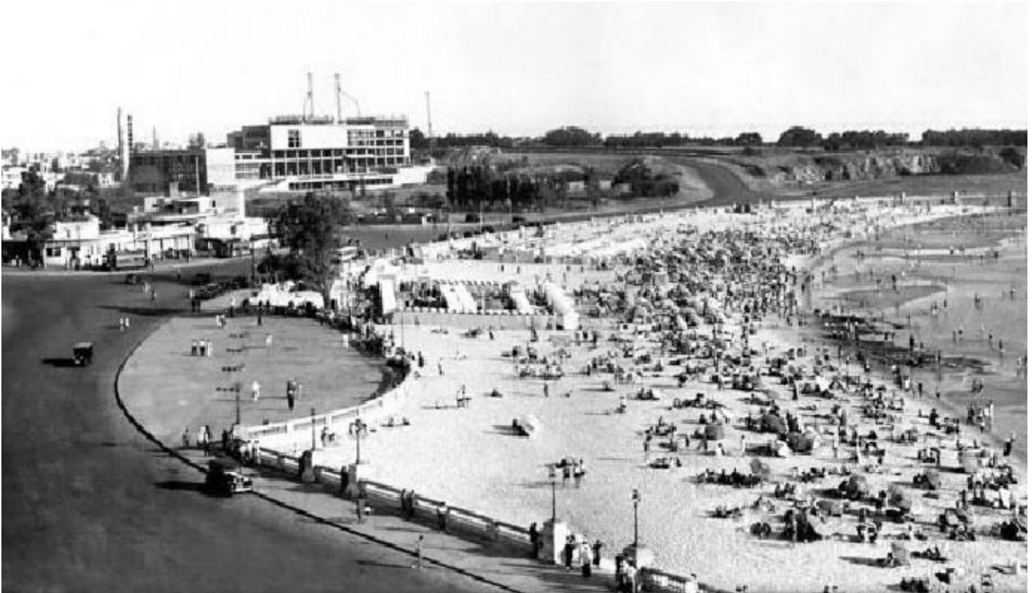
Foto de 1940. Comienzo de la construcción del edificio de FING (todavía no aparece el Cuerpo Sur).
