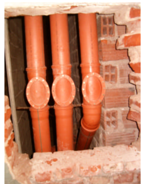
Se completaron los trabajos de cambio del trazado de los desagües pluviales de la azotea del Cuerpo Central y se trabaja en las instalaciones de abastecimiento de agua potable.
