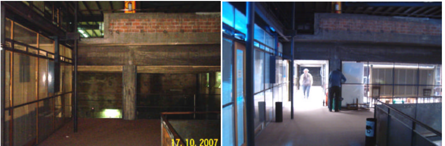
Ampliación de los entresijos metálicos del Cuerpo Norte construidos en 2008 y 2009.
