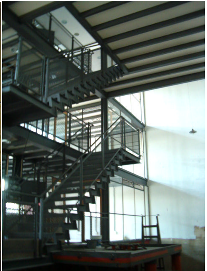
Entrepisos metálicos en el Cuerpo Sur (Instituto de Ingeniería Eléctrica) construidos en 2010 y próximos a inaugurarse.
