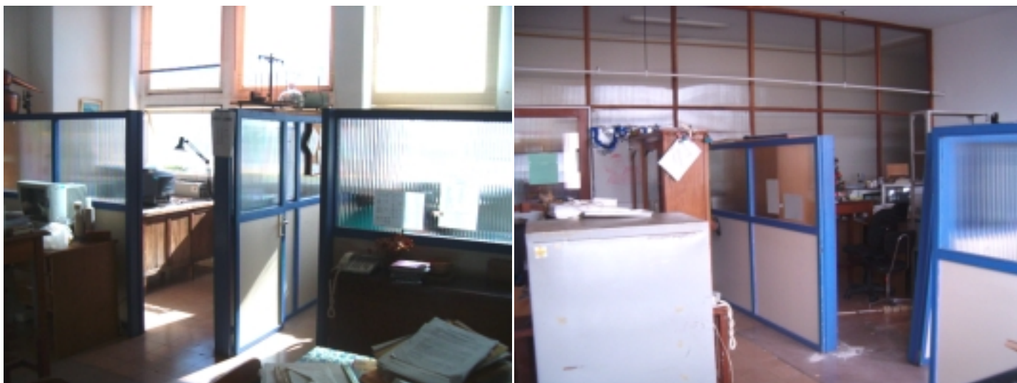
Oficina del Departamento de Bioingeniería del IIQ. Se están realizando trabajos de traslado de mamparas de madera y vidrio y las correspondientes adecuaciones de las instalaciones eléctrica y de red de datos en la oficina del referido departamento. Los trabajos son realizados por el Plan de Obras y Mantenimiento.
