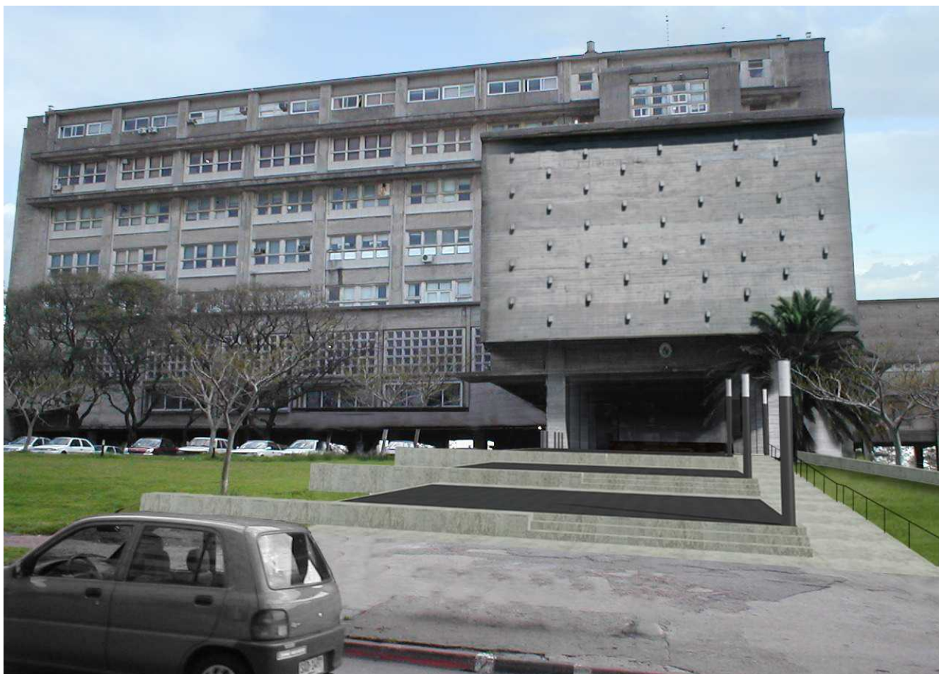
Adecuación de accesos
