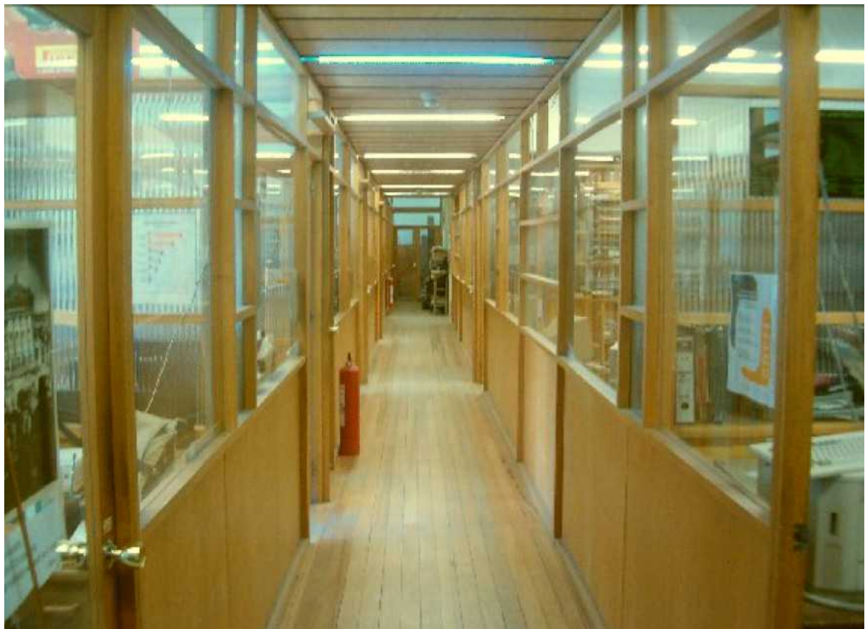
Construcción de oficinas en entepiso del Instituto de Ingeniería Eléctrica
