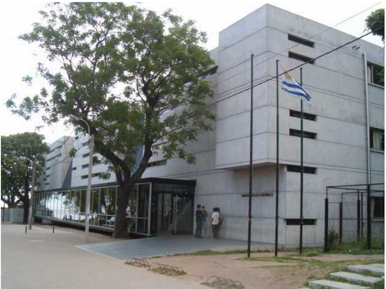
Construcción del Edificio Polifuncional José Luis Massera
