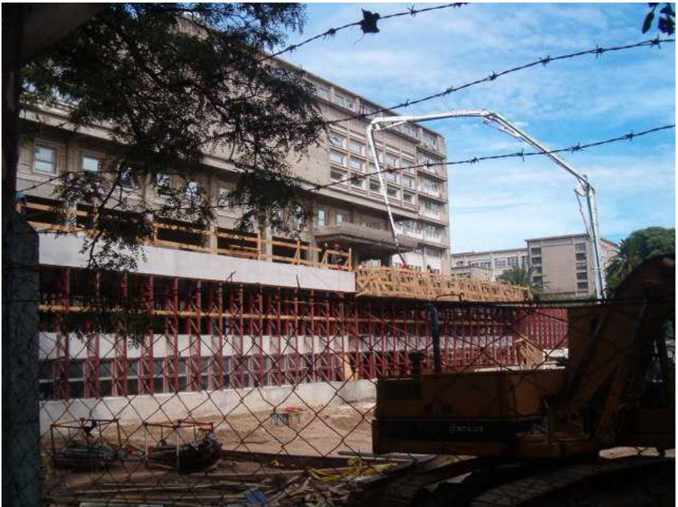
Construcción de nuevo edificio para el Instituto de Computación
