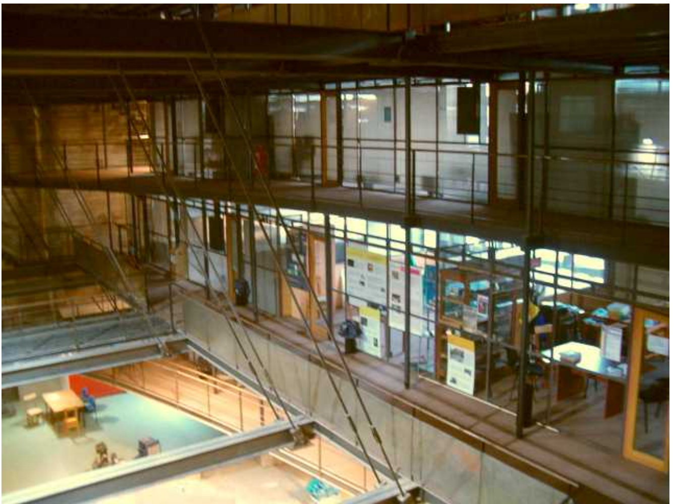
Construcción de Entrepisos Metálicos en el Cuerpo Norte
