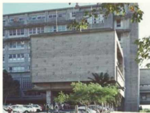
Faculdade de Engenharia: em primeiro plano a entrada sob o volume da sala de conferências; logo atrás os dois corpos centrais elevados – o mais baixo, à direita, ilude-se a Sala de Máquinas. Foto Ricardo Rocha
