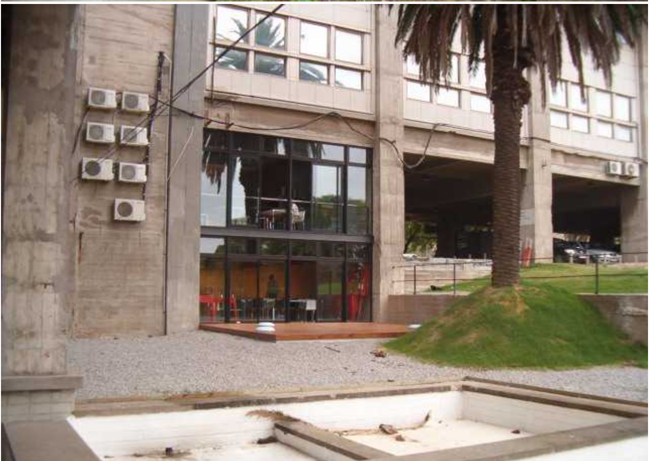
Construcción de la nueva Cantina y recuperación de espacios adyacentes
