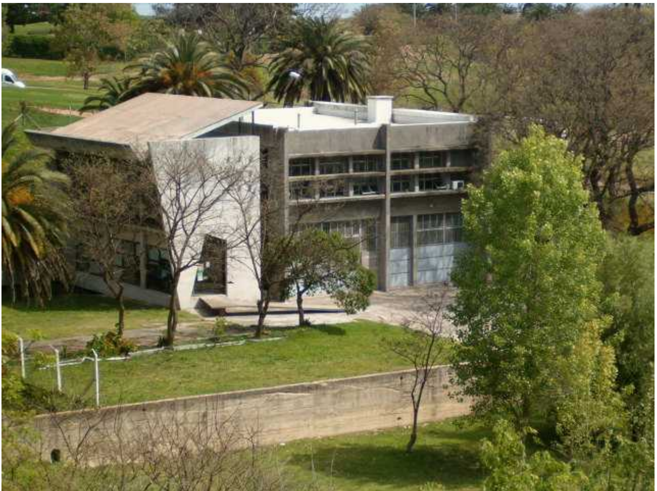
Ampliación del edificio Anexo
