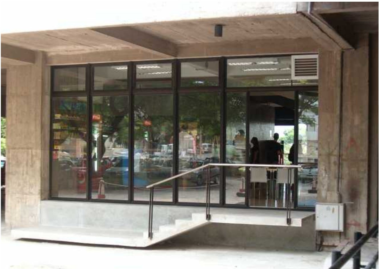
Construcción de la nueva Cantina de Facultad
