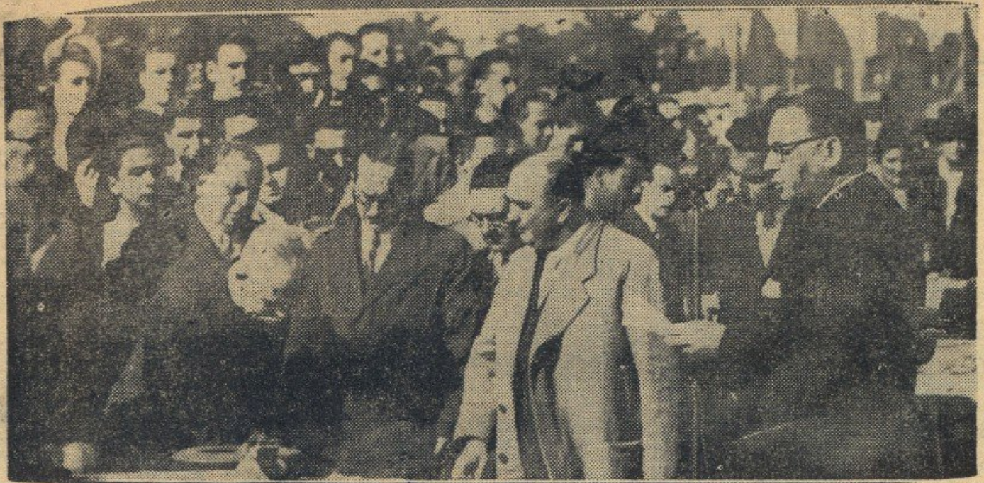
El Decano de la Facultad de Ingeniería, señor Luis Giorgi, pronunciando su discurso en el acto de la colocación de la piedra fundamental
