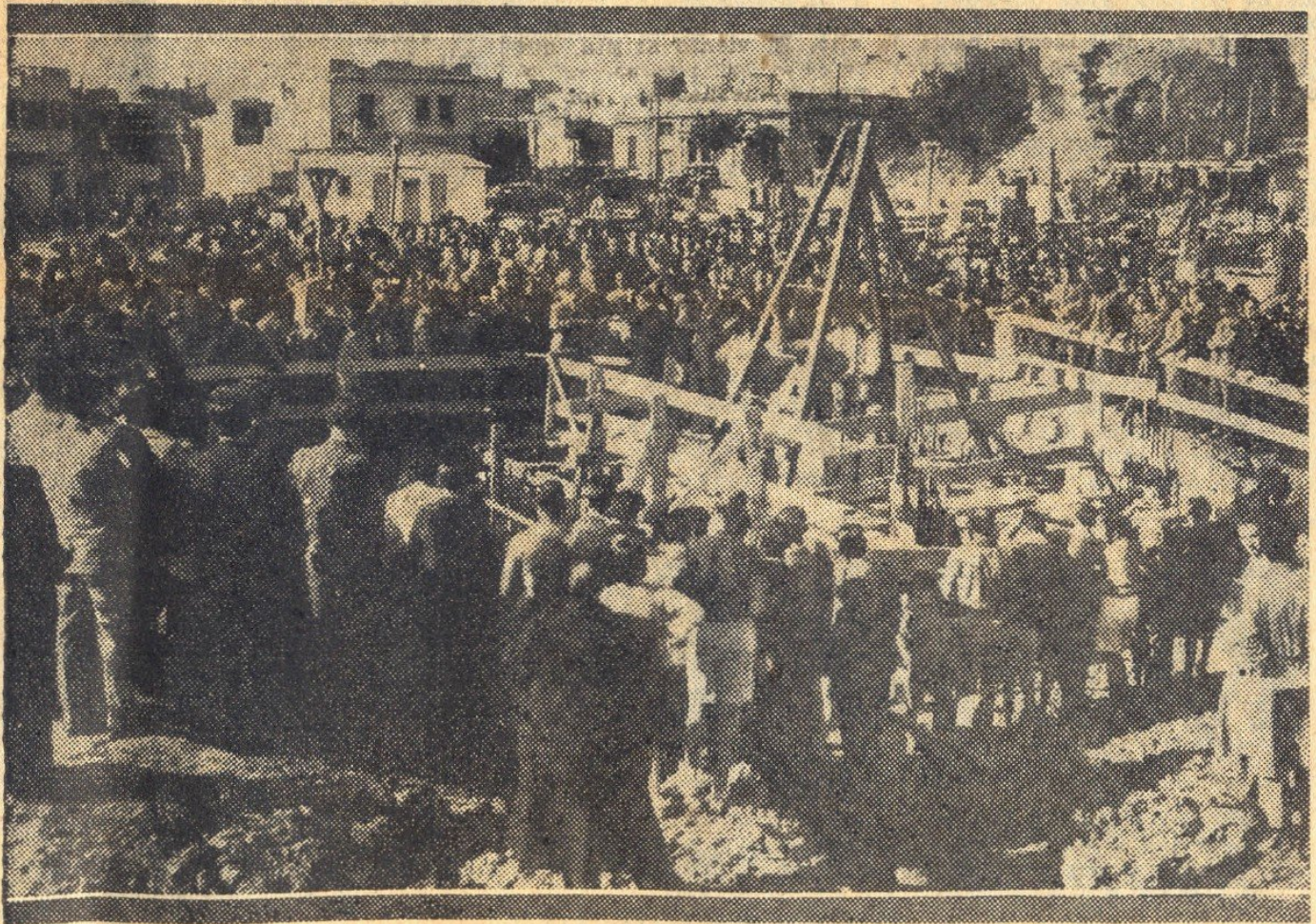
Instante en que se procede a la colocación de la piedra fundamental del futuro edificio de la Facultad de Ingeniería situado en las cercanías del Parque Rodó, más allá del lugar que ocupa el "field" del Club Atlético Defensor.
