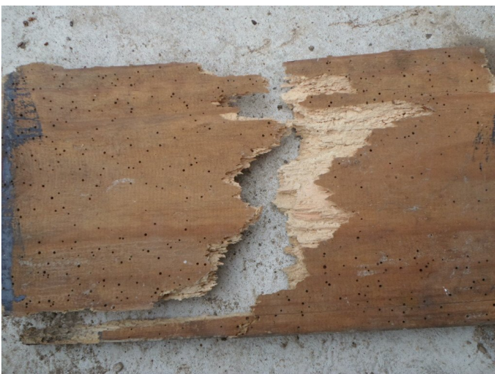
Además se sustituyeron todos los escalones apolillados de la escalera interior.
