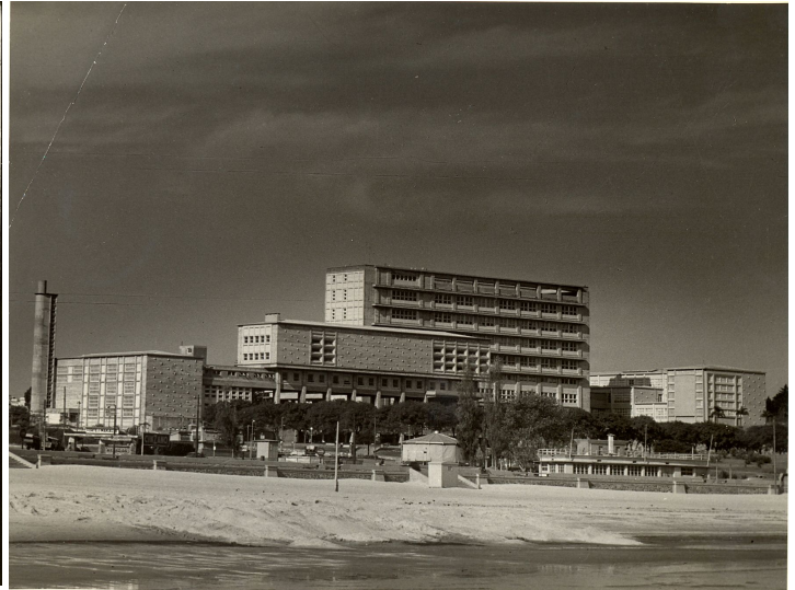
Actual edificio de FING
