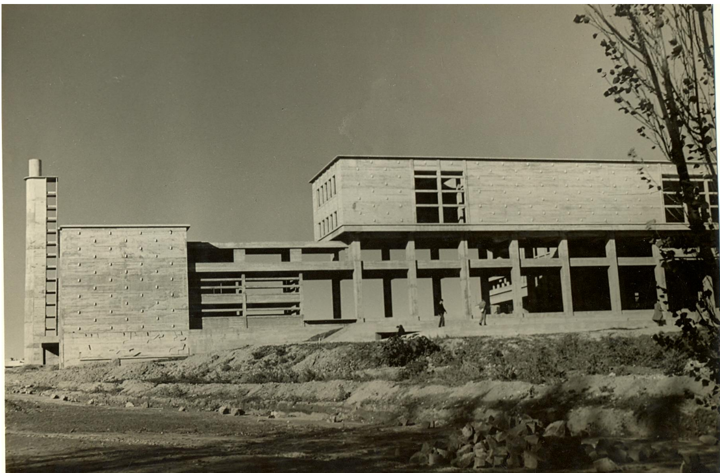
Avance de los trabajos en el Cuerpo Norte y Biblioteca Central (fachada oeste)
