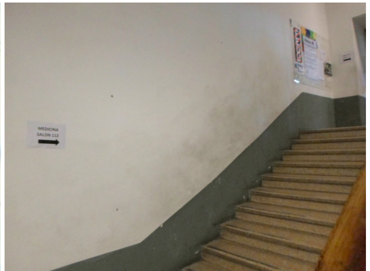
Un cartel de papel donde empieza la escalera, otro a la mitad, y otro al final. ¿acaso tengo opción luego que entro a subir la escalera? ¿no es redundante tanto cartel?
