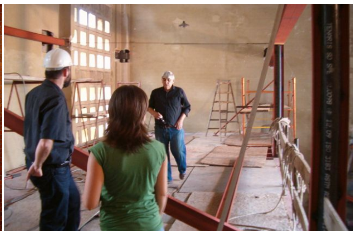
Ing. César Fernández durante la obra de los entrepisos metálicos en el Instituto de Ingeniería Eléctrica (marzo de 2010)
