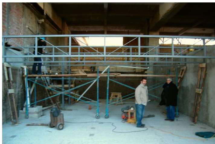
Ing. César Fernández durante la obra de la nueva Cantina de facultad (julio de 2009)
