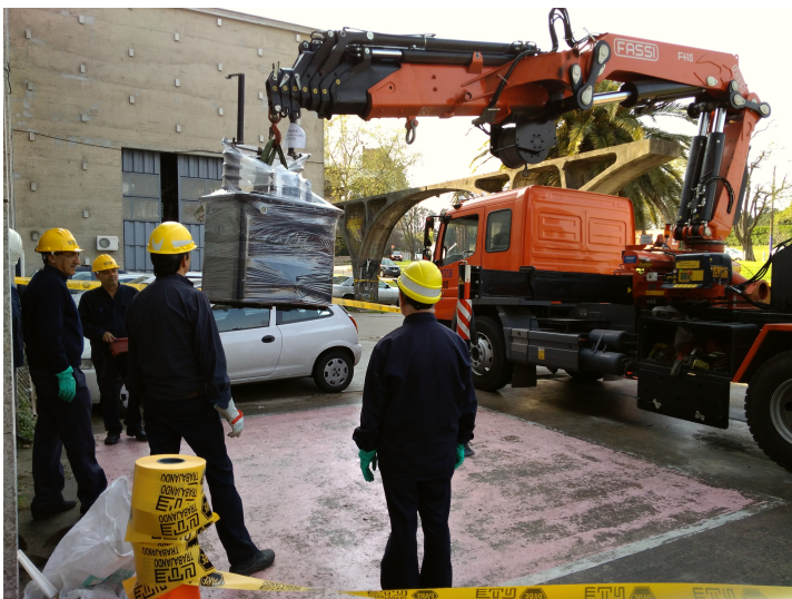
Foto retiro transformadores Betiana Epifanio - IIE.
