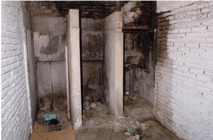
Vestuarios masculinos en 1997, antes de las obras
