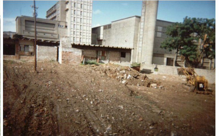
Foto de 1997 cuando comenzaron los trabajos de recuperación
