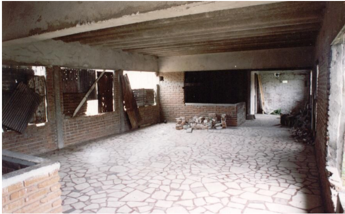
Foto del salón principal en 1997, luego de la limpieza
