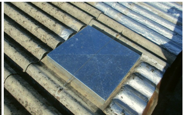
Tapas en accesos a sobretechos del Cuerpo Sur. Se realizó por parte de la empresa Constrac Ltda. el suministro y colocación de tapas de chapa galvanizada para los accesos al sobretecho del Cuerpo Sur.
