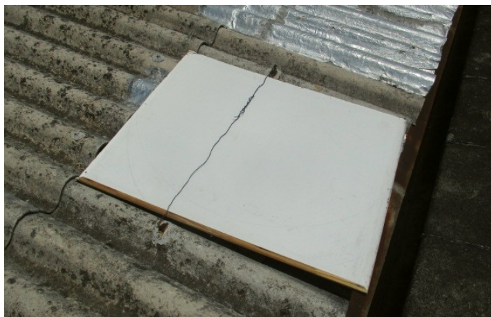
Tapas en accesos a sobretechos del Cuerpo Sur. Se realizó por parte de la empresa Constrac Ltda. el suministro y colocación de tapas de chapa galvanizada para los accesos al sobretecho del Cuerpo Sur.
