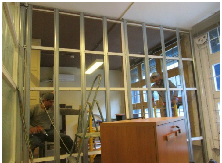
Tabique de yeso en oficinas del IMFIA. Se realizó por parte de la empresa Constrac Ltda. la colocación de un tabique de yeso con aislación acústica entre 2 oficinas del IMFIA en el 3er subsuelo del Cuerpo Norte.
