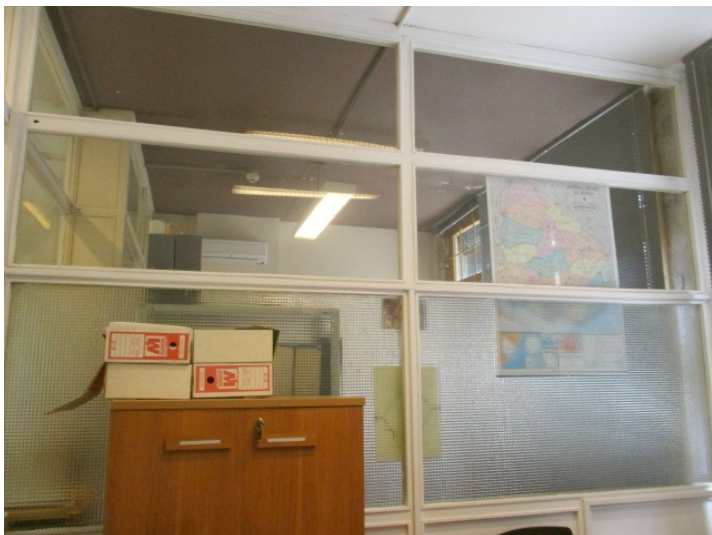
Tabique de yeso en oficinas del IMFIA. Se realizó por parte de la empresa Constrac Ltda. la colocación de un tabique de yeso con aislación acústica entre 2 oficinas del IMFIA en el 3er subsuelo del Cuerpo Norte.
