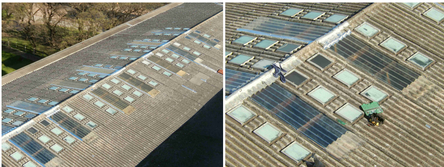
Los trabajos fueron realizados por la empresa Constrac Ltda..
