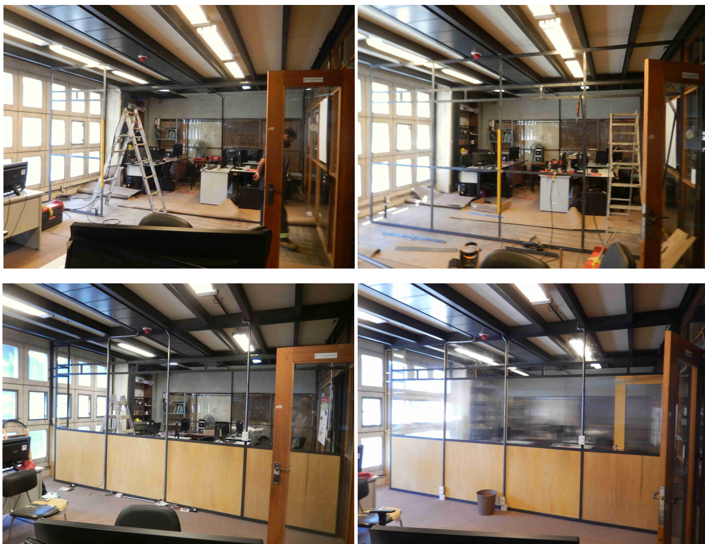
También se realiza la adecuación de las instalaciones eléctricas y de redes de datos.
