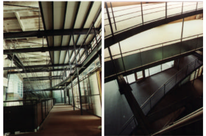
Readequación de la antigua Sala de Máquinas: Facultad de Ingeniería, Montevideo, Uruguay 5
