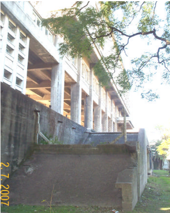
Estado actual de la escalera proyectada.
