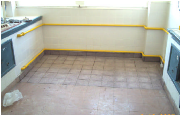
Demolición de mesadas y mejor aprovechamiento del espacio.
