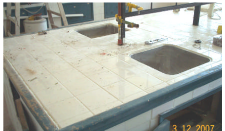
Cambios en las mesadas: azulejos, posición de piletas, instalaciones de agua potable
