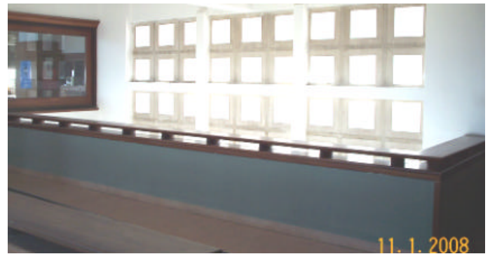
Hall y pasillo del 3er. Subsuelo del Cuerpo Norte. Durante el pasado mes de enero se realizaron los trabajos de mantenimiento de albañilería y pintura de paredes.
