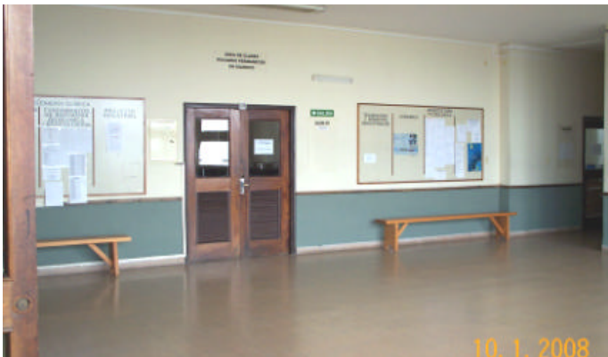
Hall y pasillo del 1er. piso del Cuerpo Central. Durante el pasado mes de enero se realizaron los trabajos de mantenimiento de albañilería y pintura de paredes.
