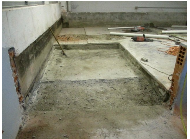
Se avanza con trabajos de demolición (para la construcción de una rampa), construcción de un muro y realización de desagües sanitarios.
